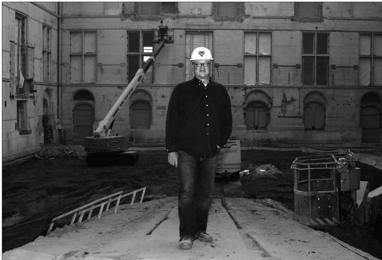
Jan Willem in de leeggehaalde oostelijke binnenhof van het Rijksmuseum. Licht en lucht zijn terug. In totaal is er 13.000.000 kilo sloopafval verwijderd uit het museum. (Foto Anja Daleman)
